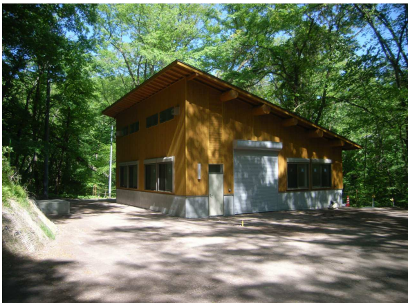
水車小屋全景
