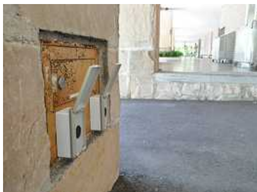
ザ・プリンス 箱根本館に設置した低速充電設備
