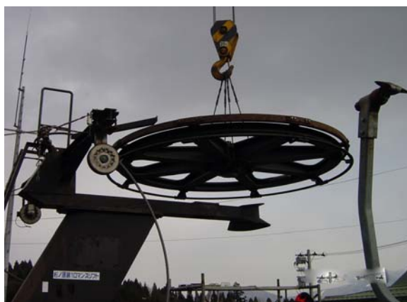
折り返し滑車ベアリング交換（妙高）
