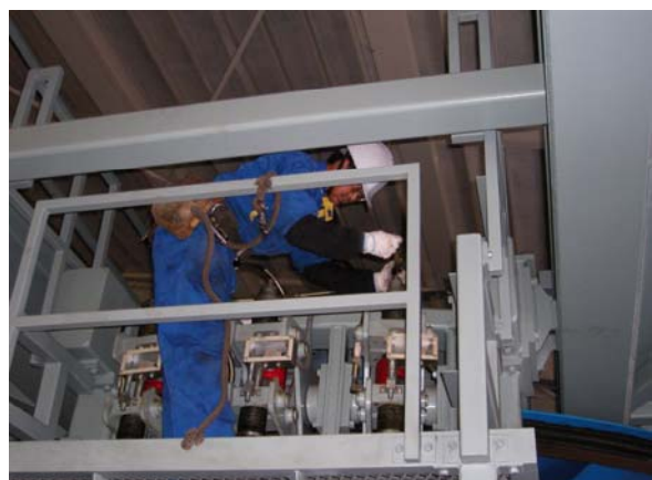
妙高ゴンドラブレーキ点検作業
