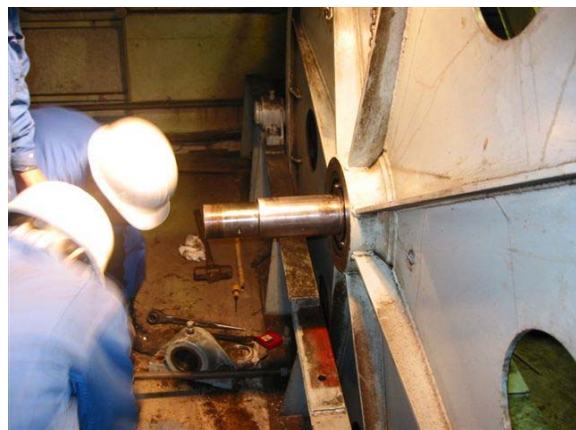
田代ロープウェイ誘導滑車へアリング交換
