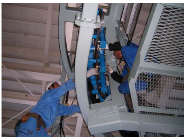
ゴンドラ押送装置解体整備作業（妙高）
