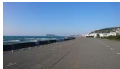
⑤西側方面を撮影。 晴れた日には富士山が 顔を出す最高の ロケーション
