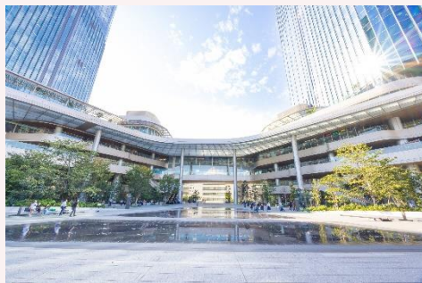
TAKANAWA GATEWAY CITY (画像提供: JR 東日本)
