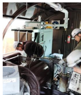
苗場 L火打第1ロマンスリフト 予備原動機更新工事
