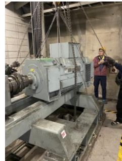
妙高 A杉ノ原ゴンドラ 電動機オーバーホール工事
