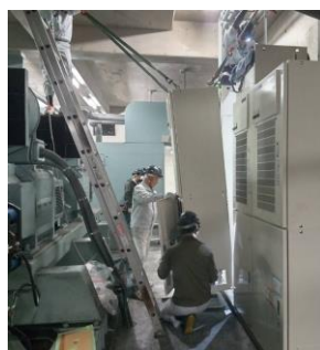
苗場 DG 苗場-田代ゴンドラ 制御盤更新工事
