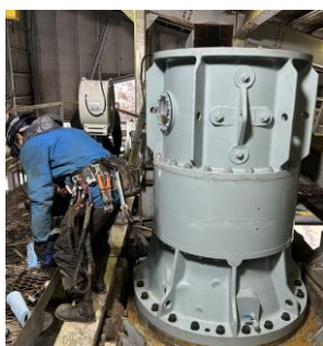
富良野 Bダウビル第1高速リフト 減速機更新工事
