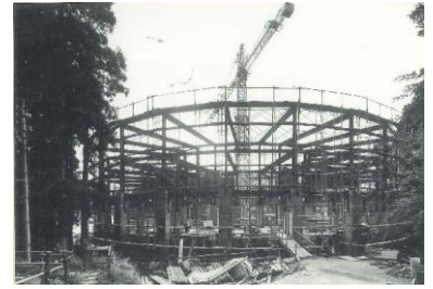
建設中の本館
