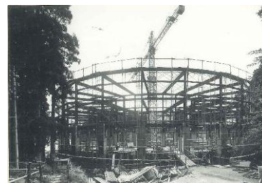
建設中の本館
