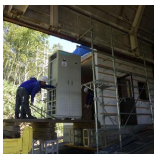
焼額山第3高速リフト 制御盤更新工事
