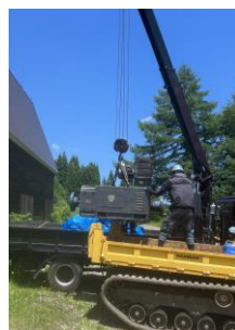
妙高第3高速リフト 電動機オーバーホール工事
