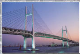
横浜ベイブリッジ Yokohama Bay Bridge
