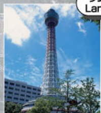
マリンタワー Marine Tower
