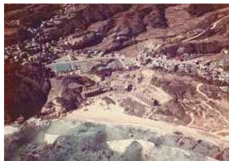
建設中のホテル全景
