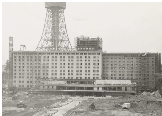
1964年開業に向け建設中の東京プリンスホテル
